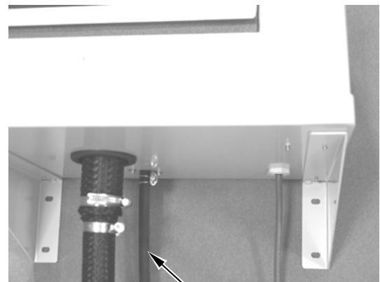
凝縮水ホース
