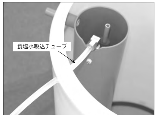
(写真-13) 自動弁への食塩水吸込チューブの接続
