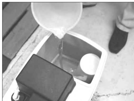
（写真-17）食塩タンクへの張水
